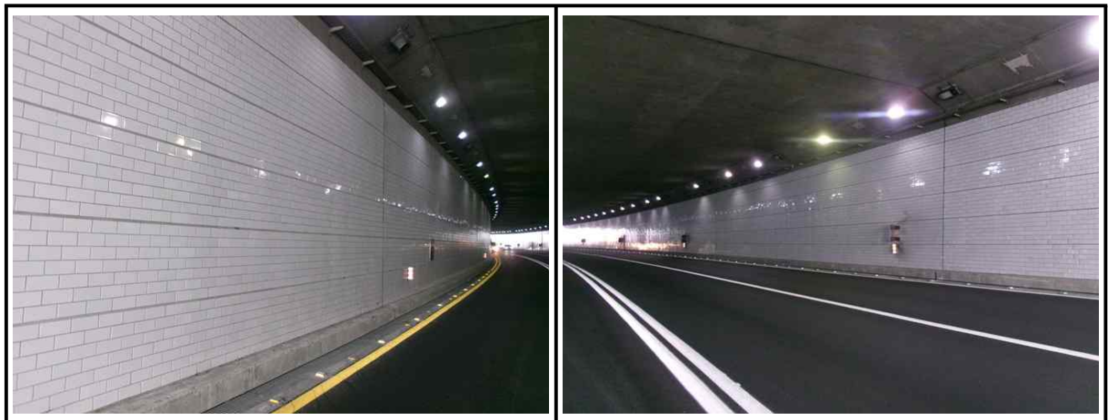
【사진 1.3.6】 BOX구간 벽체 전경
