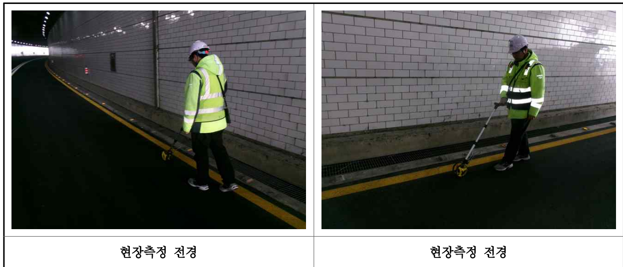
【사진 1.2.1】 부재 현장측정 전경
