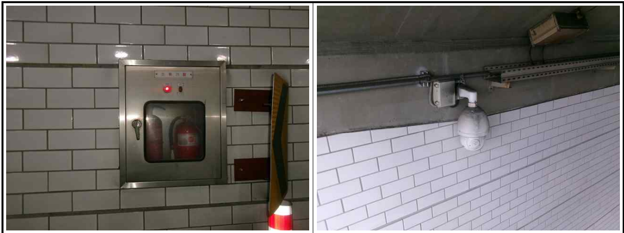
【사진 1.3.12】 부속시설 전경
