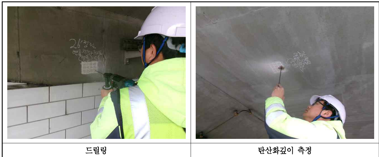
【사진 1.4.3】 탄산화 깊이 측정 현장사진
