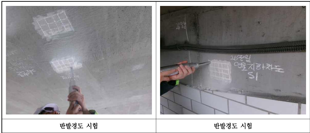
【사진 1.4.2】 반발경도시험 현장사진
