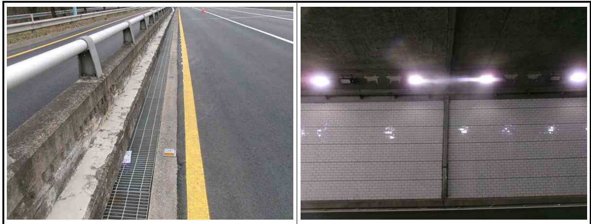
【사진 1.3.10】 배수시설 전경
