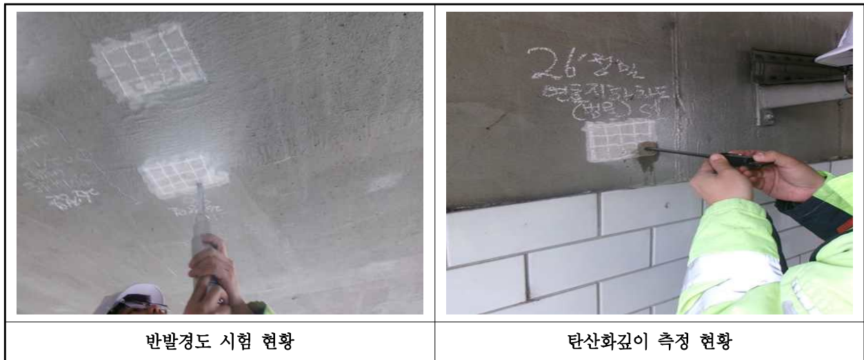
【사진 1.4.1】 콘크리트 내구성조사 현황
